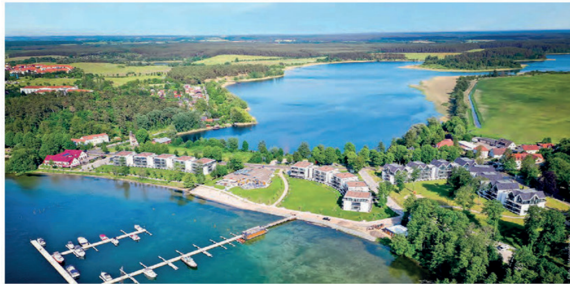
Maremürzt Yacht-hafen Resort & Spa: Über 184 Ferienwohnungen, Restaurant, Spa und Hafen verfügt die Anlage des Preisführers 12.18.
